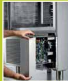
Cuadro eléctrico extraíble facilitan la manutención
